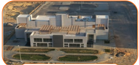
المبنى الإداري والبنك
